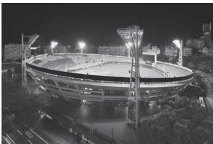
横浜スタジアムの照明設備
