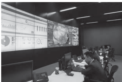
コントロール室
